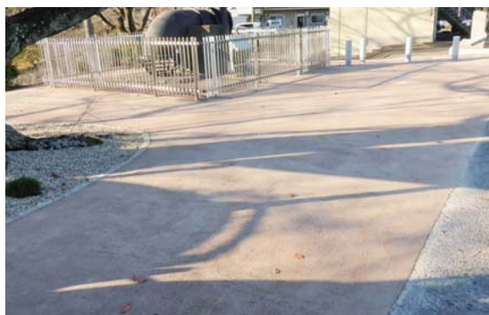
<世界かんがい施設遺産・入鹿池> 記念石碑周辺舗装
